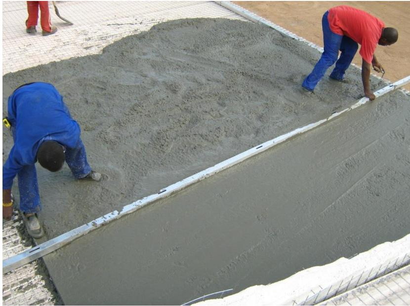
En función de la curva de endurecimiento del hormigón o mortero aplicado, y previa verificación estructural se procederá al desapuntado de las losas para completar la 2da. capa de recubrimiento inferior de acuerdo a las especificaciones. A los fines solamente indicativos y para luces moderadas puede desapuntarse a los 14 días.
