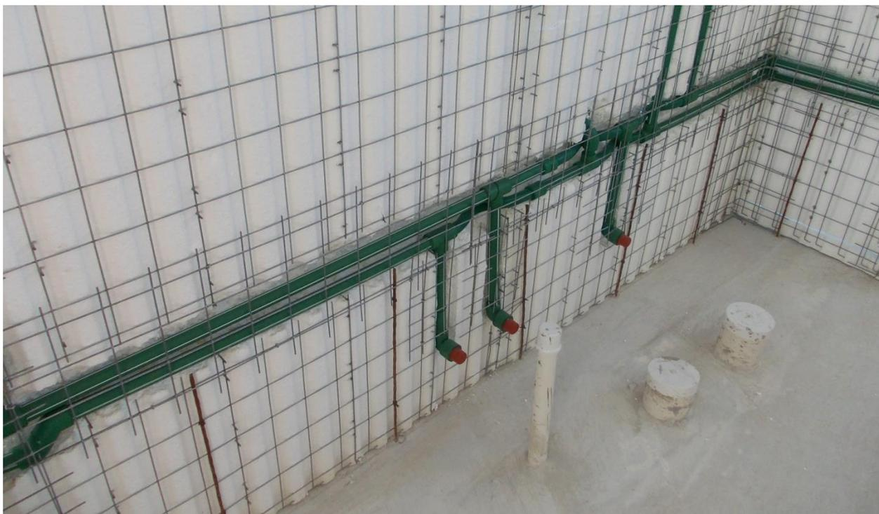
(se corta la malla para alojar el tubo con precisión y una vez colocado se repone con el accesorio de malla plana RG2)
